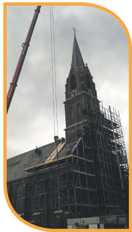
Renovatie kerktoren Rijpwetering
